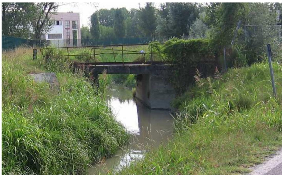
Inoltre, la presenza di botti a sifone di dimensioni ormai insufficienti al transito delle portate di piena al di sotto del Taglio di Mirano crea, oltre alle citate difficoltà di deflusso delle acque, condizioni di rischio idraulico per la possibilità di cedimento dei manufatti sollecitati dalle nuove forze venutasi a creare.
