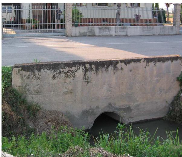
I problemi della bonifica dipendono dalla parziale inadeguatezza della rete di bonifica per le mutate condizioni di urbanizzazione e per la riduzione degli invasi e delle sezioni dei canali attraverso tombinamenti con canne di diametro inadeguato.
