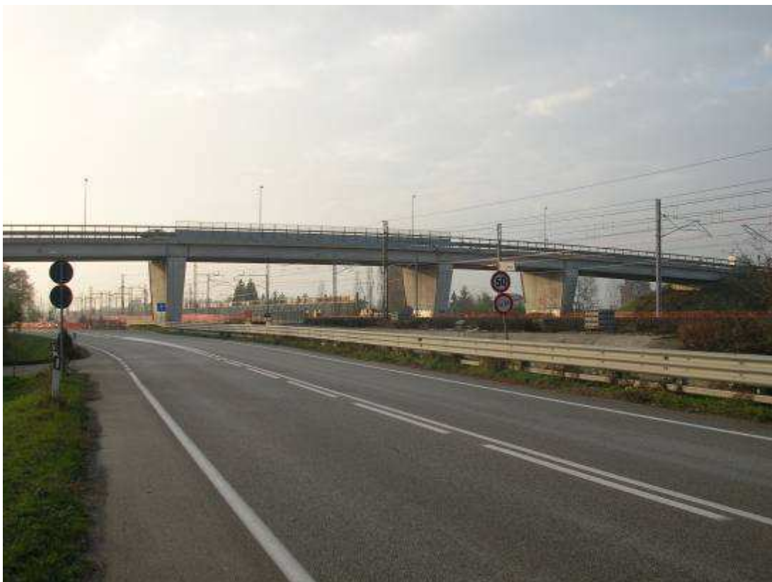
Immagine n. 40 – Cavalcaferrovia a sud-est del capoluogo. L'impatto visivo, oltre che ambientale, risulta inesistente. (Fonte: Pizzato - Rampado, 2007)
