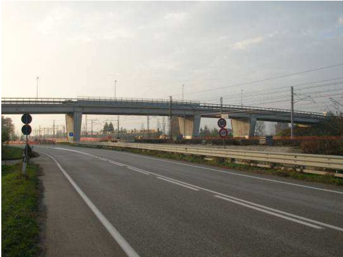
Immagine n. 40 – Cavalcaferrovia a sud-est del capoluogo. L'impatto visivo, oltre che ambientale, risulta inesistente. (Fonte: Pizzato - Rampado, 2007)
